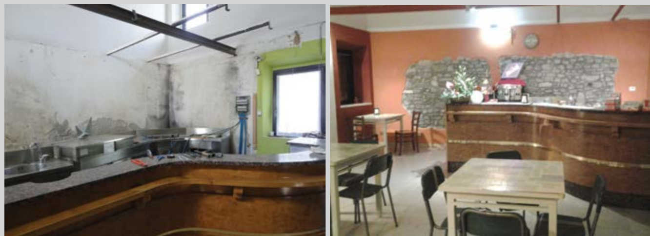
Un particolare dei locali prima e dopo i lavori di ristrutturazione.
